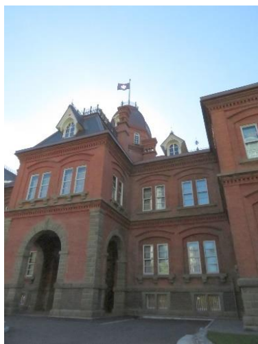
銅板が吹き替えられて赤銅色になった八角塔
