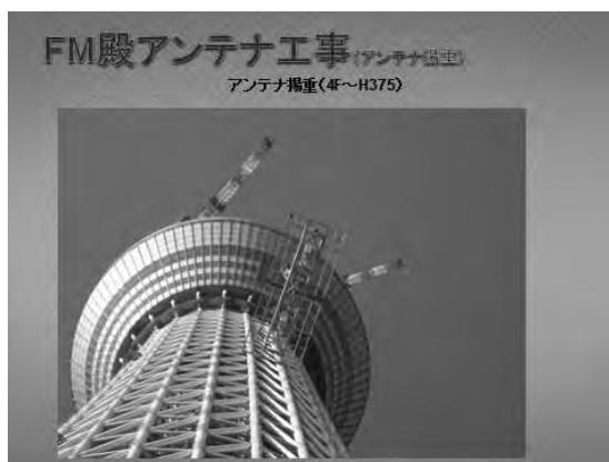
図3 東京スカイツリー®タワー用アンテナ工事（アンテナサイズ7m×3m）（重量約1000kg含む架台）
