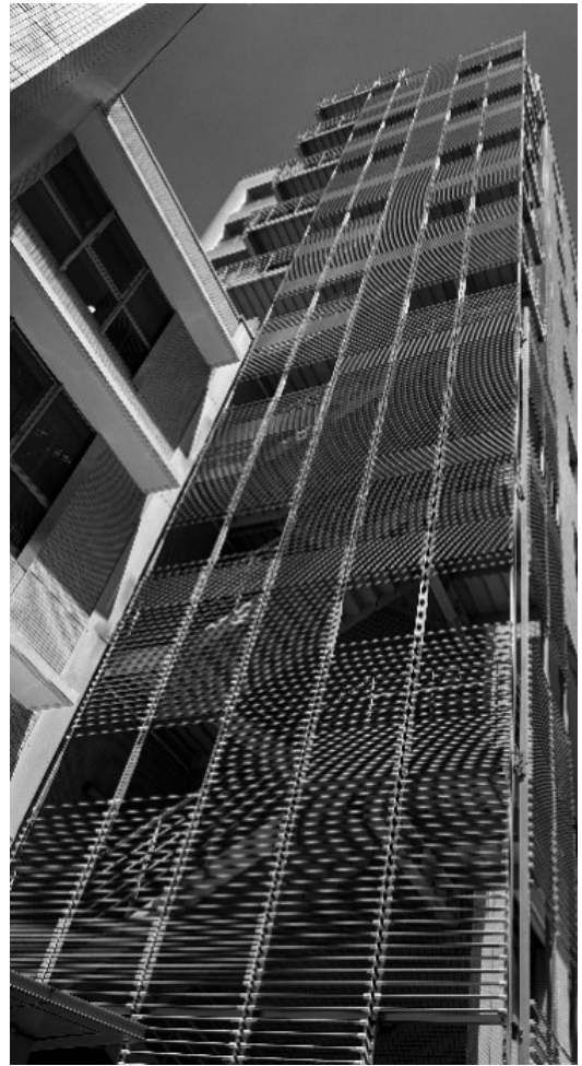
東3号館外部階段に設置された 円筒形太陽電池の大規模実証設備
