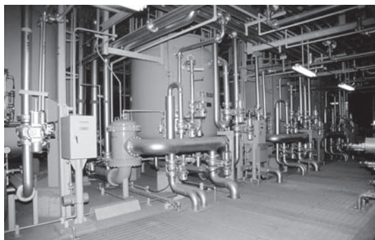
第3図 原子力発電所向：復水脱塩装置
